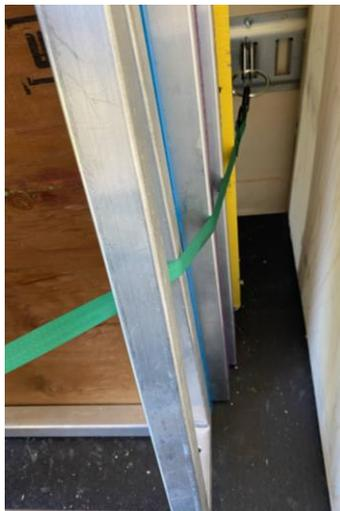
2. Espace pour l'ancrage au mur suffisant. Module bien positionné.
