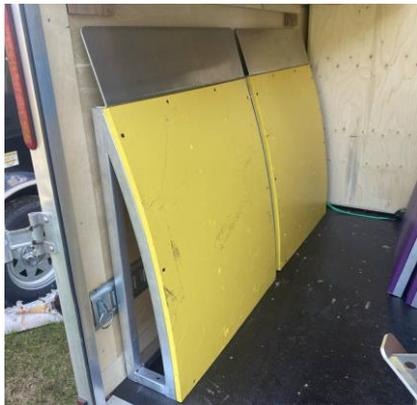
1. Installer les deux pièces du module jaune côte à côte. (s'assurer de laisser de l'espace de dégagement pour les ancrages sur le mur).
